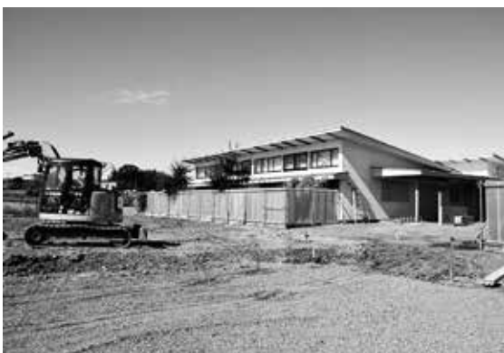
増改築工事が始まったわかあゆ保育園
