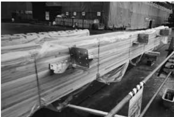
長さ16m、幅22cm、高さ70cmの梁部材
