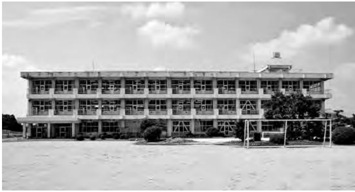
改修される小川中学校管理室棟
