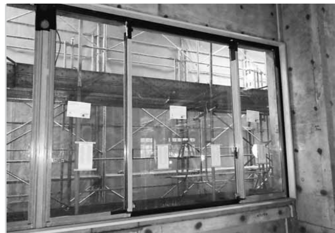
サッシ取付状況
