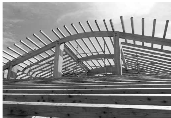
議場屋根景観
