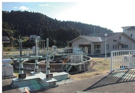
下水処理施設（馬頭浄化センター）
